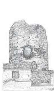
Visuale della Torre prima dell'intervento di restauro
